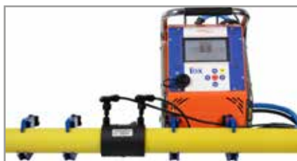
11. Inicio de la soldadura.
