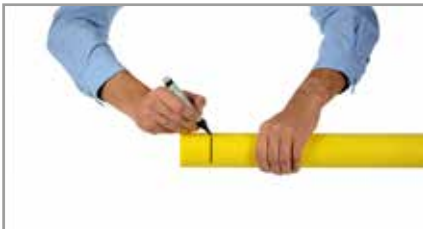
7. Marcar la profundidad de inserción del tubo.
