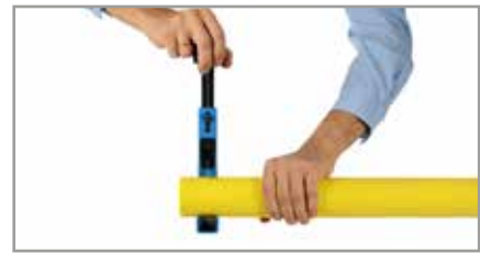
3. Cortar el tubo de forma totalmente recta.
